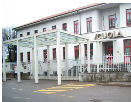
Tettoia - Scuola Primaria
