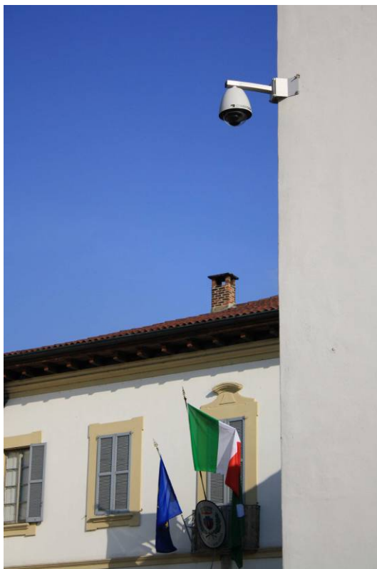
Una delle telecamere dell'impianto di videosorveglianza
